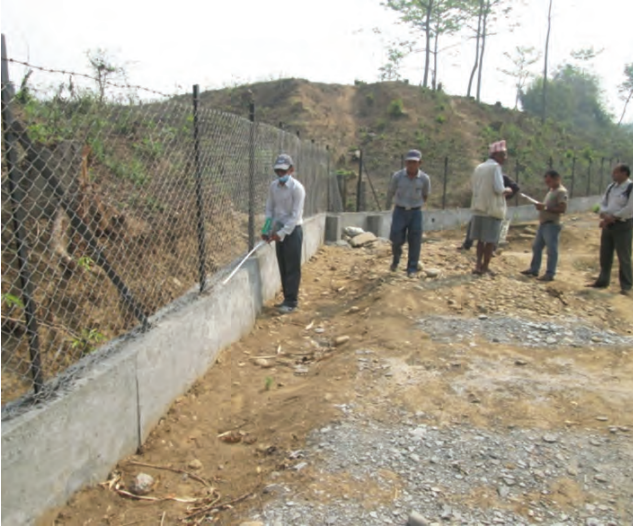
केरुङ्गा उपभोक्ता समितिको डि.पि.सी.सहितको मेसजाली निर्माण कार्यक्रम
