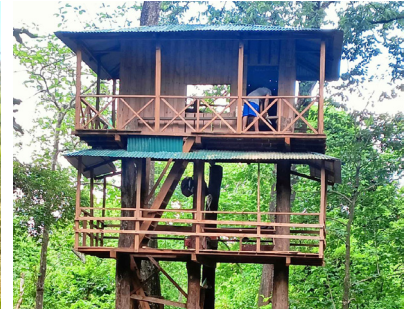
नयाँ काठको भ्यू टावर निर्माण
