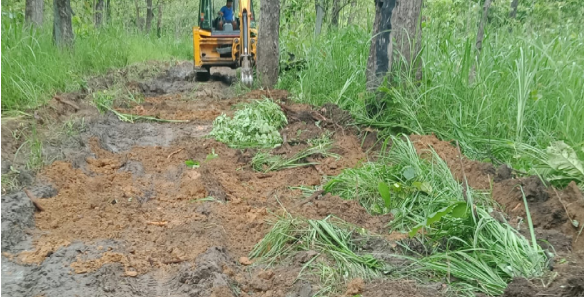
गोरेटो बाटो निर्माण
