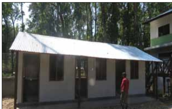
मेडिकल स्टोर निर्माण
