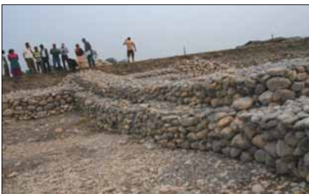
तटबन्ध निर्माण, गोसाईबाबा उ.स., प्रसौनी, नवलपरासी
