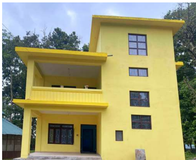
कसरा पोष्ट भवन
