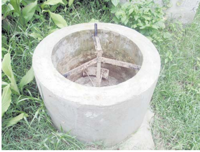
बुढीराप्ती उपभोक्ता समितिको क्षेत्रमा निर्माण गरिएको गोबरग्याँस प्लान्ट
